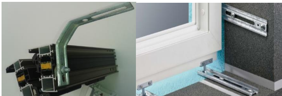
Σχήμα 3.9: Στερέωση κάσας με κουμπωτές λάμες.
