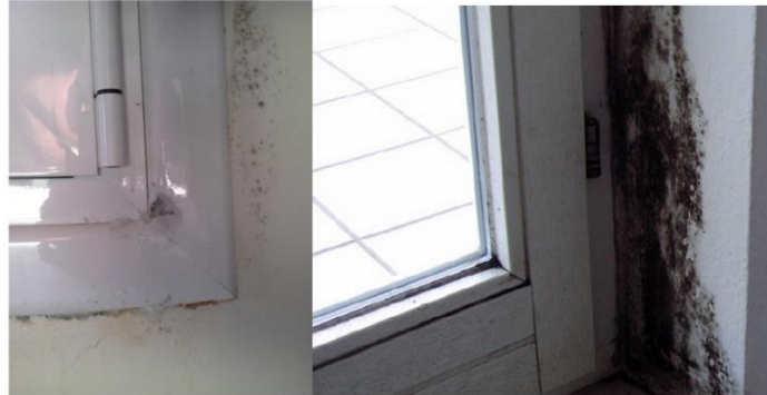
Εικόνα 4.1: Παραδείγματα δημιουργίας μούχλας λόγω κακής στεγάνωσης.
